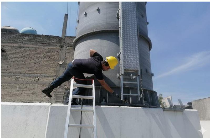
Imagen 21. Inspección de Cimentación con Anclajes de Torre.
