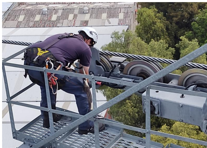
Imagen 18. Inspección de Guiado del Cable en Pilonas
