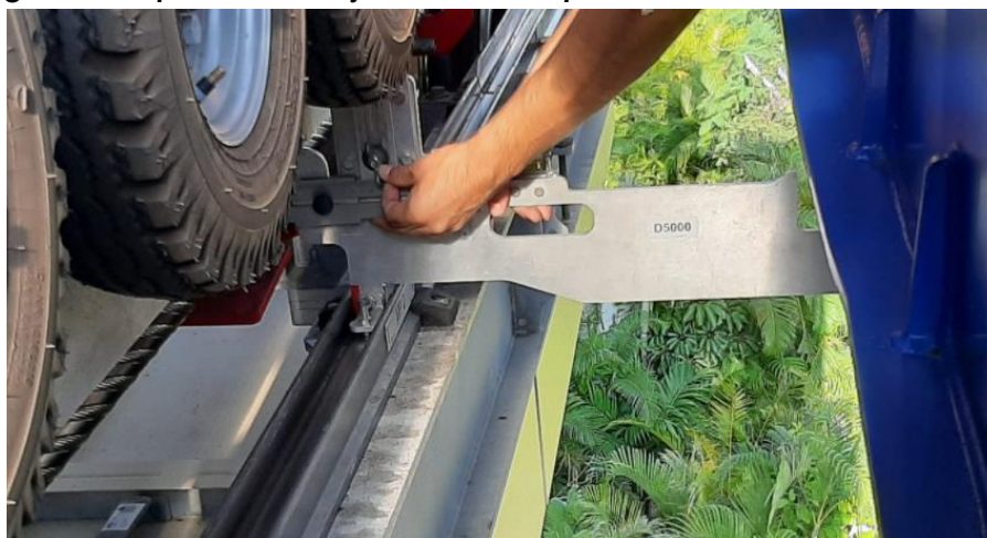
Imagen 19. Inspección de Ajuste de Interruptores Geométricos del Teleférico.
