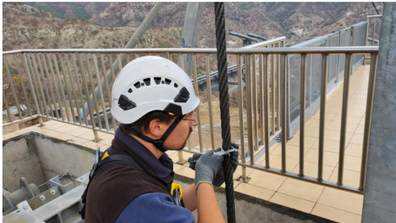
Imagen 20. Medición de Diámetro Real de Cable Tractor en Teleférico Tipo Vaivén.
